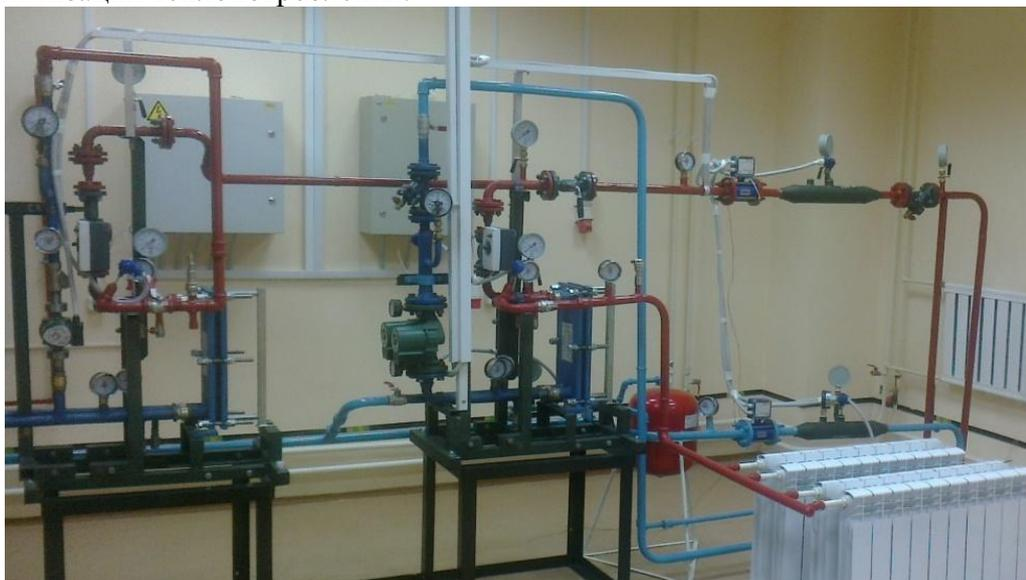
Рисунок 1 – Автоматизированный тепловой пункт «Взлет АТП».
